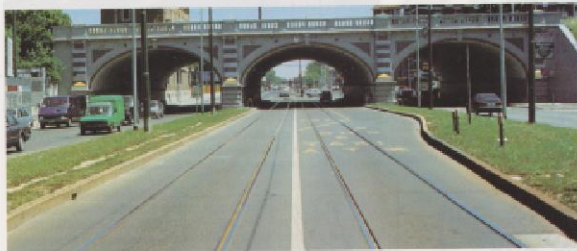
Abb. 1: Frontansicht der Eisenbahnunterführung »Passaggio Nord«.
