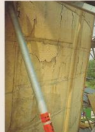
Il passaggio in Viale Forlanini prima dell'intervento di manutenzione e ristrutturazione.
