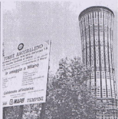
La torre dell'acqua decorata con mosaici (Foto Borsotti)
