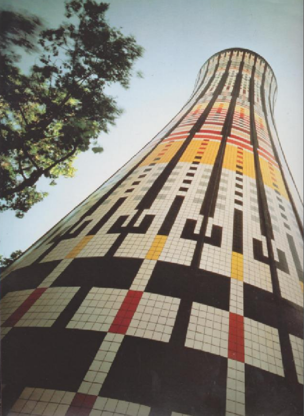
Nella pagina a fianco il rivestimento in ceramica realizzato con piastrelle regolari Marazzi di diverse dimensioni, forme e 22 colorazioni (picchi, progettati per essere in armonia con la struttura originale della torre.
